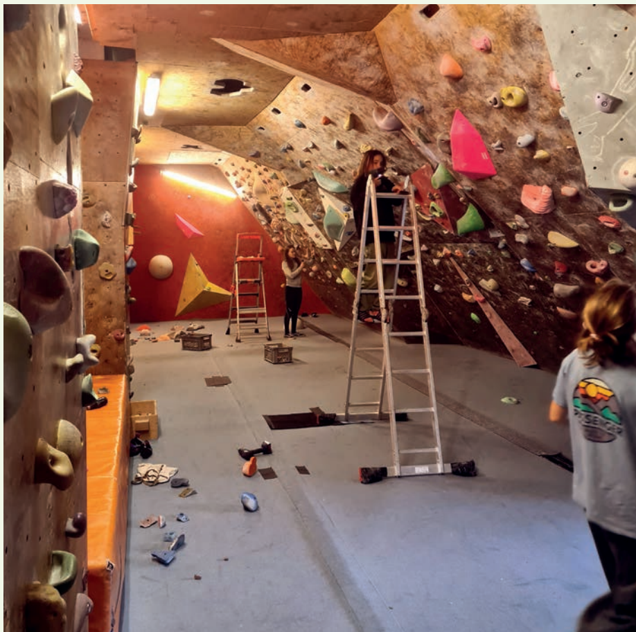
Auffüllen der Wände mit „neuen“ Griffen
