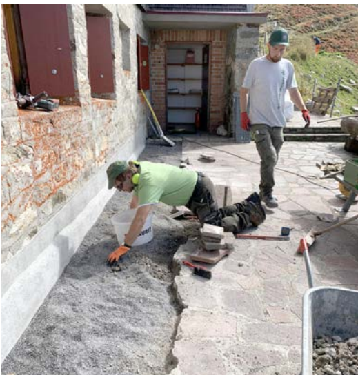
Verlegearbeiten Südterrasse Kaltenberghütte
