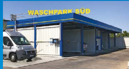
SB-Waschpark Süd am Südbahnhof
